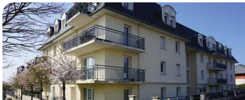
Résidence édiée par Edifides
