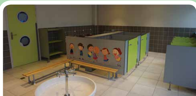
Réfection des sanitaires
