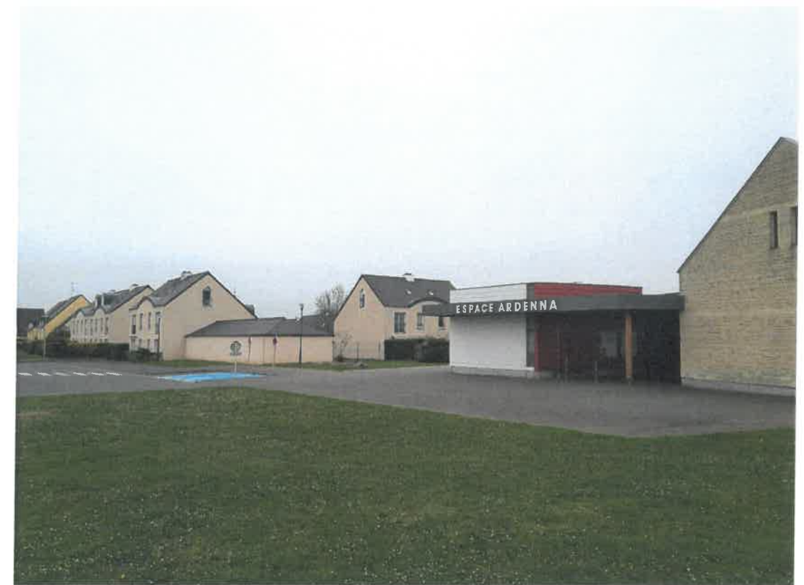
PC7.3: Vue sur l'Espace Ardena depuis la RD220C,; Vue depuis le Sud-Ouest
