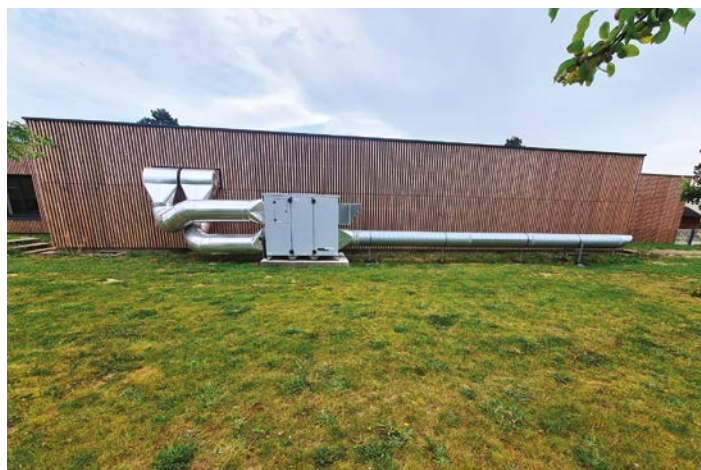
Centrale de Traitement de l'Air
